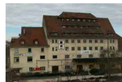
Eine historische Aufnahme des Speicherhauses (Bild 1) und darunter vor der Sanierung.
