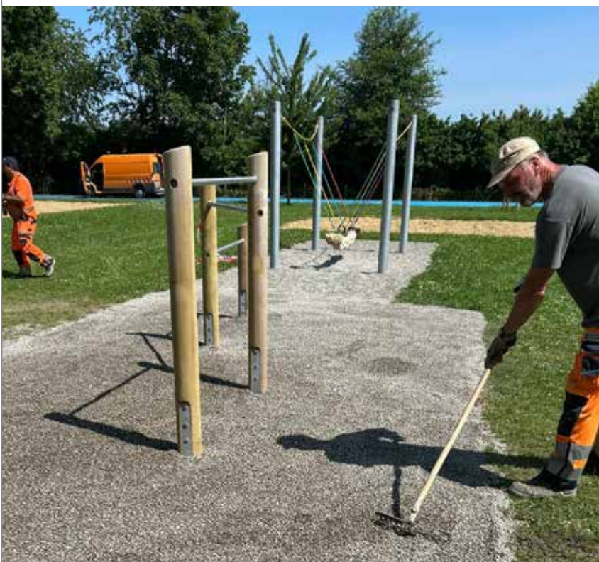
Fleißige Mitarbeiter des Ortsbauhofes Taldorf beim Aufbau der neuen Spielgeräte.
