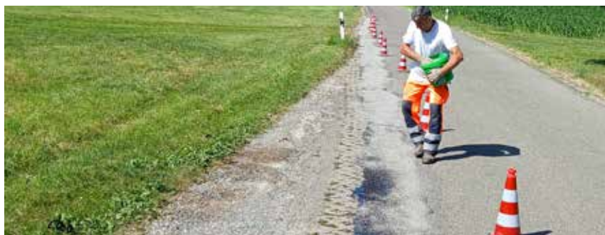
Hier wird der Straßenrand zwischen Wolfsberg und Unterwolsberg von einem Mitarbeiter des Schmalegger Bauhofs ausbessert. Foto: Ortsverwaltung Schmalegg
