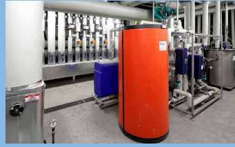
Bild: Technische Werke Schussental (TWS)
