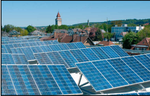
Bild: Technische Werke Schussental (TWS)
