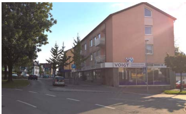
Bestandssituation, Blick nach Süden / Goetheplatz
